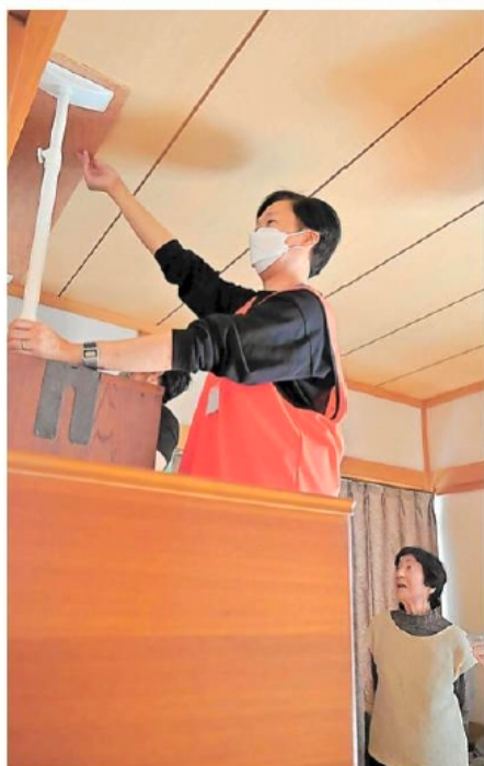
たんすの上に転倒防止器具を設置するサポート隊員 || 21日午前、松山市古川南3丁目
