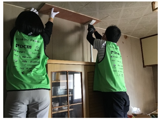
転倒防止器具の取り付け
