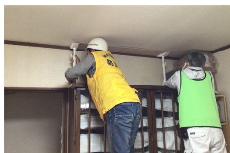
家具転倒防止器具の取り付け
